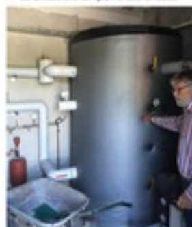
La chaudière tampon d'eau chaude
